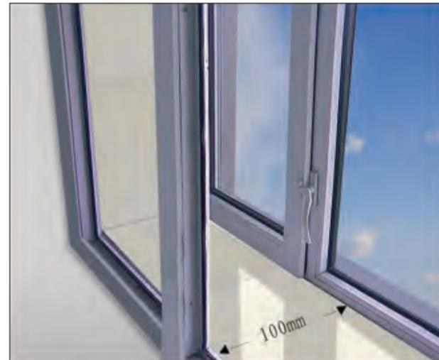
安装内窗(可采用塑钢窗+单片玻璃或中空玻璃与外窗间隔100mm, 密实内窗和周围墙体的缝隙)
