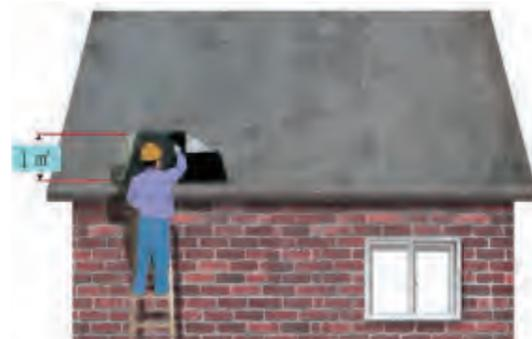
防水层施工前应保证找平层的干净、清洁。干燥程度的简易检测方法:将1m<sup>2</sup>卷材平铺在找平层上,静置3-4小时后掀开检查,找平层覆盖部位与卷材上未见水印即可。
