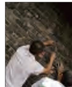
钢丝网水泥砂浆修补裂缝图
